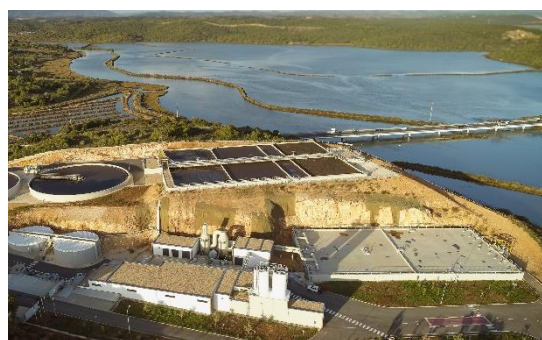
Nova ETAR da Companheira Beneficiário: Águas do Algarve, S.A.
